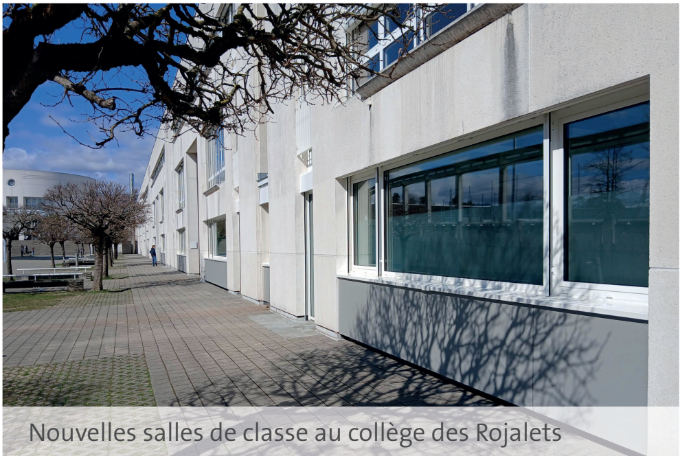
Nouvelles salles de classe au collège des Rojalets
