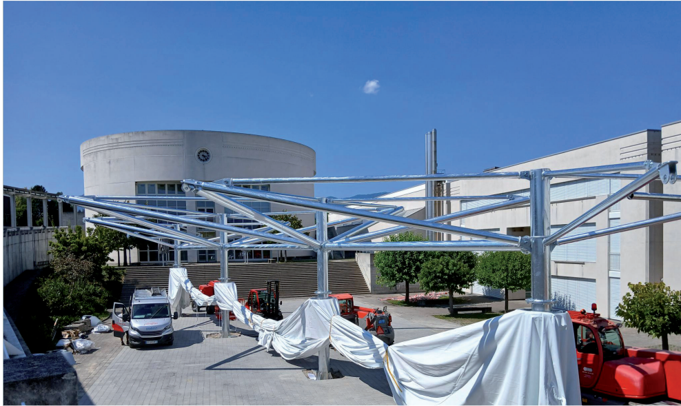
Phase de déploiement des toiles du préau
